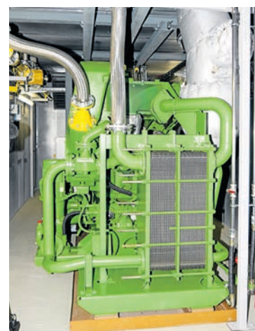
Das Kernstück: Der Motor mit einer elektrischen Leistung von rund 930 kW kann 2.000 Haushalte mit Strom versorgen
